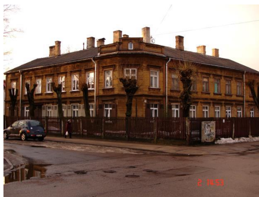
21.att. Ēka Baložu ielā 29.
