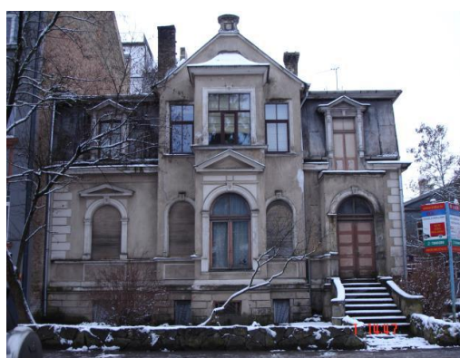
19.lpp. Ēka Baložu ielā 26.
