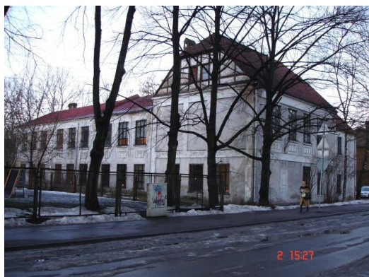
22.att. Ēka Baložu ielā 27.
